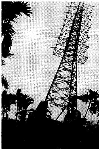
図18 傾いた送電線の鉄塔
