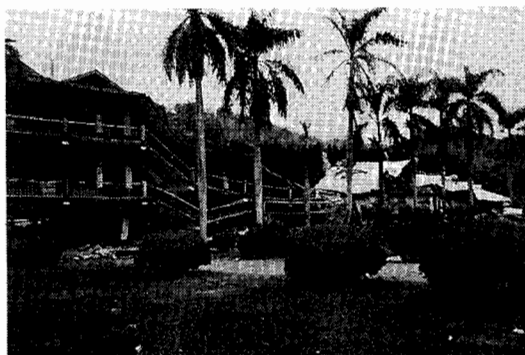
図12 崩壊した校舎
