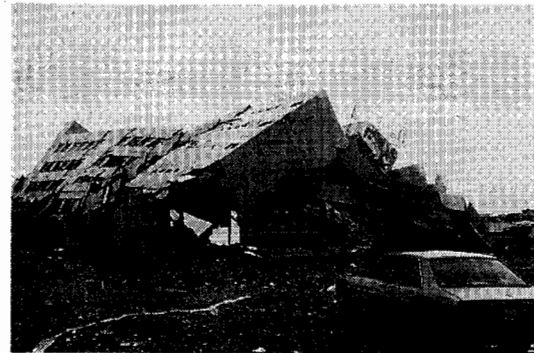
図6 7階建て大型マーケットの倒壊
